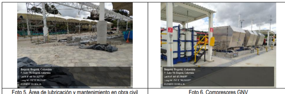
Foto 5. Área de lubricación y mantenimiento en obra civil
